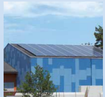
Werkgebäude, 8353 Elgg Solarstrom 56 kWp
