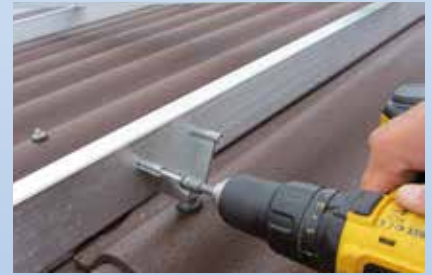
Einfach nivellieren dank Montageschlitz
