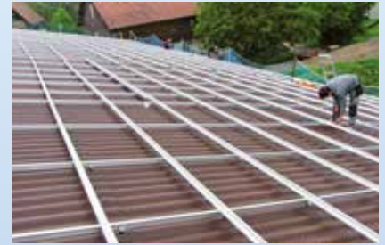
Montageschienen setzen
